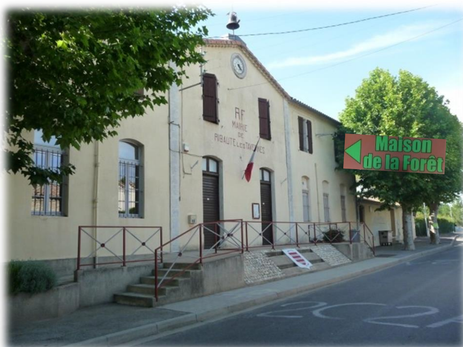
Mairie de Ribaute-les-Tavernes accueillant les bureaux du Syndicat au premier étage
